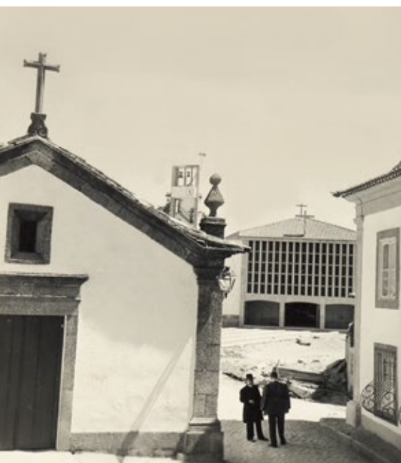
↳ Perspetiva da antiga e da nova igreja na fase final das obras
