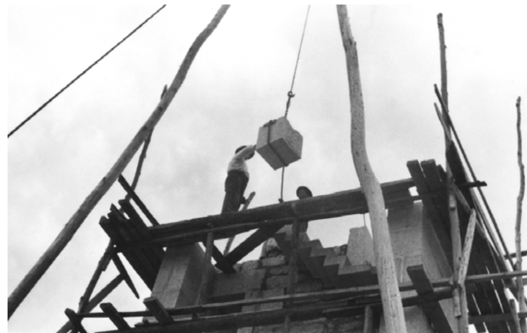
↳ Fase de construção da torre sineira
